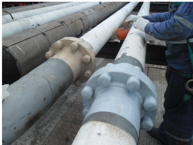
Рисунок 3 – Нанесение полимерного покрытия
