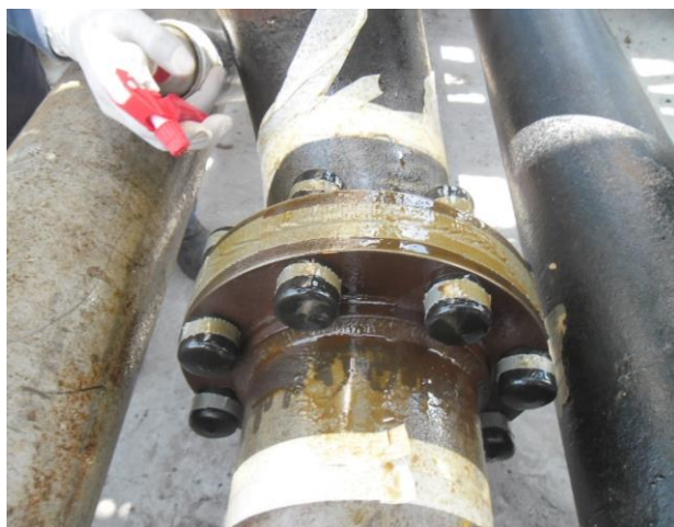
Рисунок 2 – Нанесение ингибитора коррозии
